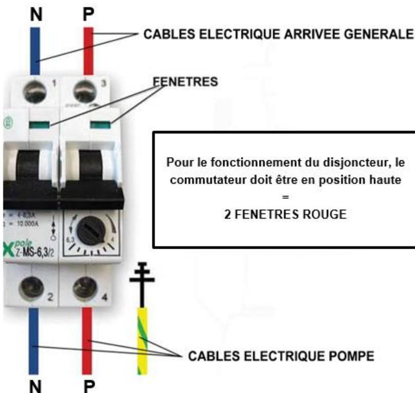
Régler le disjoncteur au bon ampérage de protection :
